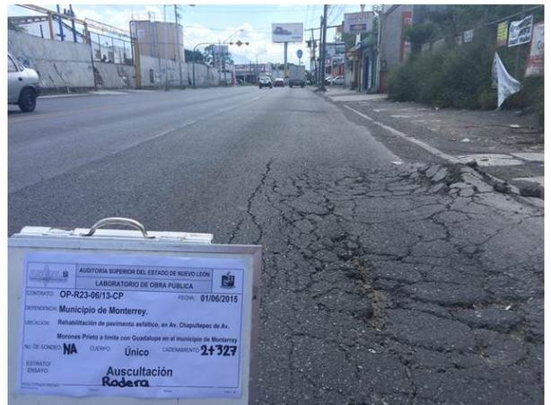
Bache en el cadenamiento 2+243, con grado de severidad alta (imagen izquierda); y rodadura en el cadenamiento 2+327 con grado de severidad alta (imagen derecha), en la avenida Chapultepec.
